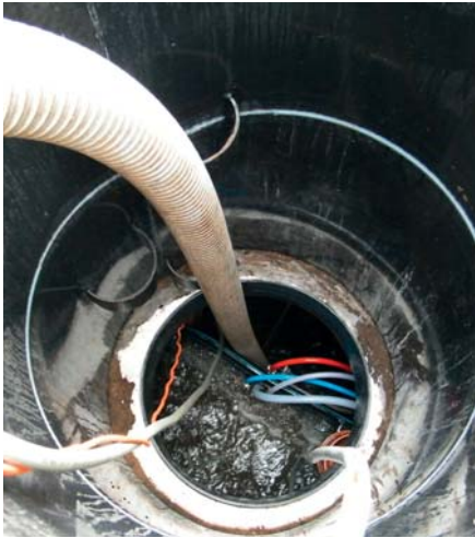
HERAUSFORDERUNG FÜR DEN PRÜFER: Polyethylenbehälter mit einem U-Boot-Turm über dem eigentlichen Behälter. BILD 10
