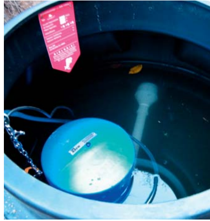
Behälter einer Kleinkläranlage mit einer Nachkläreinheit (Apuris) für die Dichtheitsprüfung auf den Prüffüllstand eingestaut. Bild 8
