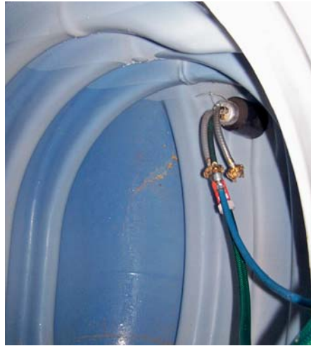
Der Einbau der Sperrblase in den Zulauf dieses Polyethylenbehälters war auch nur nach Variante 2 b möglich. Bild 11
