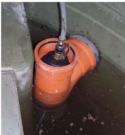
Die Sperrblase ist in vertikaler Lage in die Ablaufvorrichtung einer Kleinkläranlage eingebaut. Bild 4
