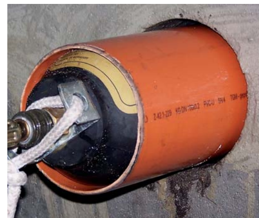
Zulaufleitung eines Betonbehälters mit eingebauter Sperrblase
