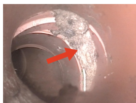
Verschobene Rohrverbindung
