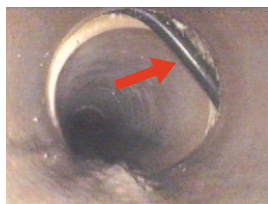
einragende Dichtung
