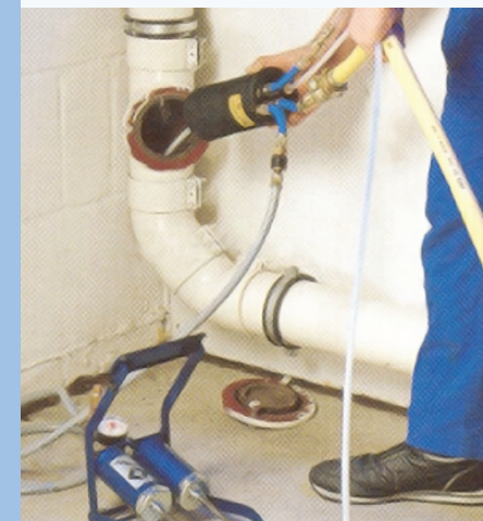
Inspektion durch Revisionsöffnungen
